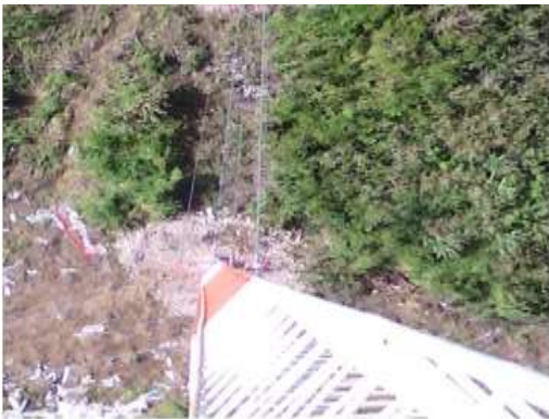
IMG 2. VISTA AEREA DE TORRE SE OBSERVA 1ER TRIANGULO ESTABILIZADOR 54 MTS
